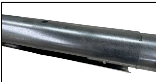
19. Pohled nasunutou spiro spojkou. Dbáme na osové vycentrování spojky dle předem připravených vyznačených míst.
