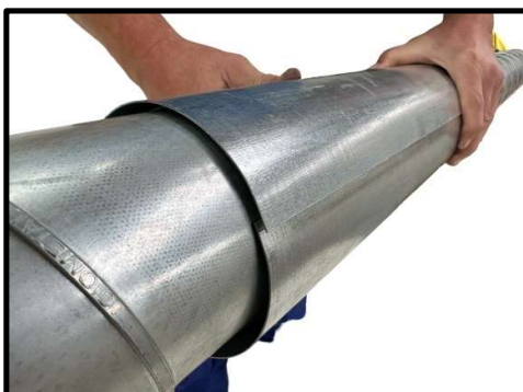
20. Obrázek překrytí při lehkém dotlačení prsty. Tlačíme na místa která jsou opatřena terostatem. Při tom je třeba dbát na to, aby horním hrana plechu překrývala spodní hranu.
