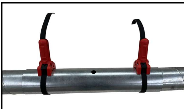
21. Po lehkém dotlačení musíme místa, která jsou opatřena terostatem dotáhnout svěrkou nebo kurtnou, která vytvoří vzhkostně těsný spoj.
